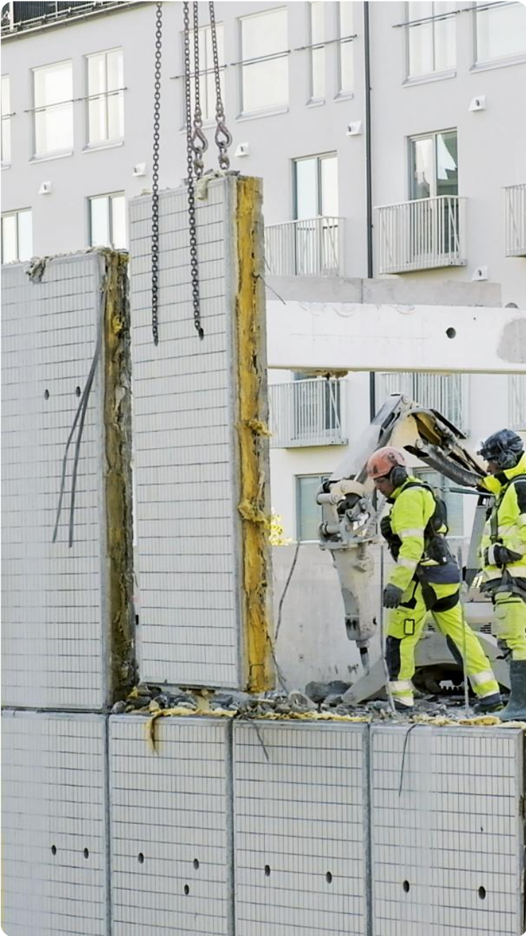
Kuva: Betoni. 2024. Betonielementtien irrottaminen ehjänä uudelleenkäyttöä varten.
